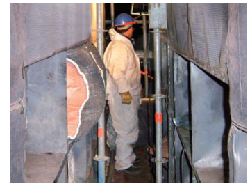
Renowacja rozgałęźnika spalin
